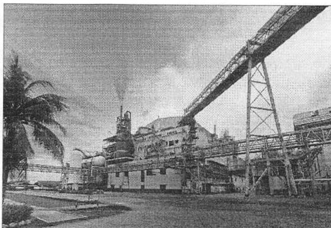
Fachada da planta
